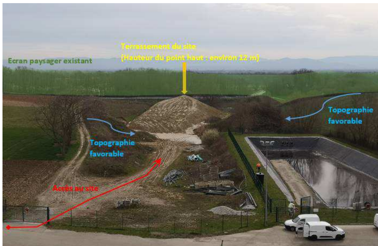
Vue légèrement en contrebas du quai de déchargement du CSDND (bâche) vers le site d'implantation du méthaniseur (Photo et production ATIP, mars 2023)
