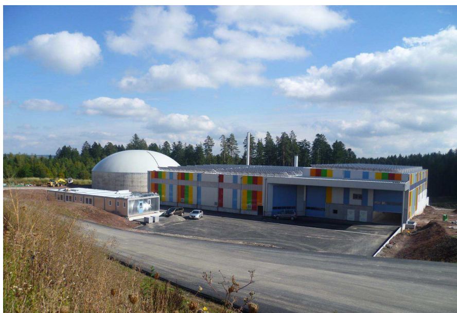
Exemple d'un hall de prétraitement avec panneaux photovoltaïques en toiture à FREUDENSTADT (Allemagne) (Sources : étude de faisabilité RYTEC, mai 2022)
