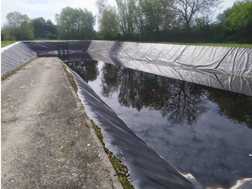
Photographie 4 : Bassin de récupération des eaux pluviales favorable aux amphibiens
