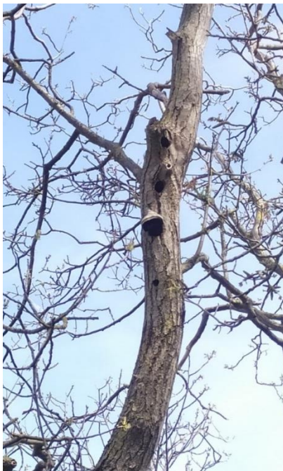
Photographie 6 : Exemple de cavités potentiellement favorables aux Chiroptères.
